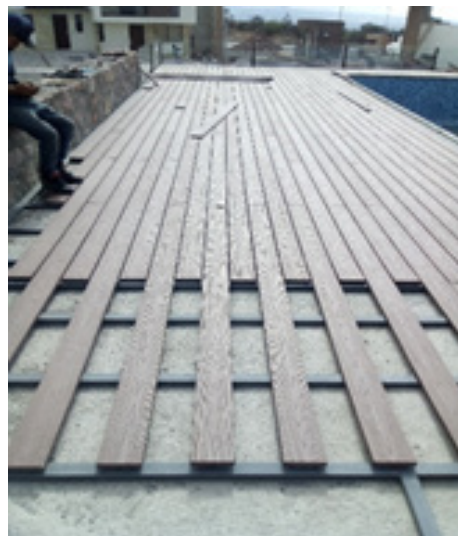
Subestructura a ras de piso
